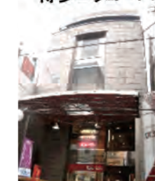
心斎橋日光ビル
